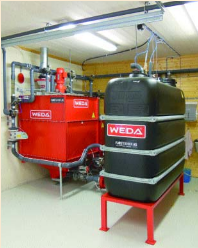
Restløslegg består av en friskvannstank, en blandetank og en brukt vannstank.
